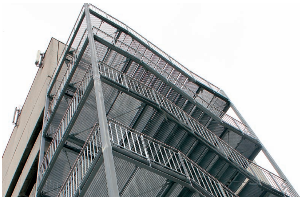
Neue Fluchttreppe am Ärztehaus Bayern
